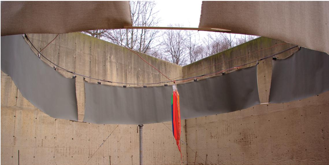
**Abb. 16:** Anordnung der Elemente zur 360°- Sprengung
